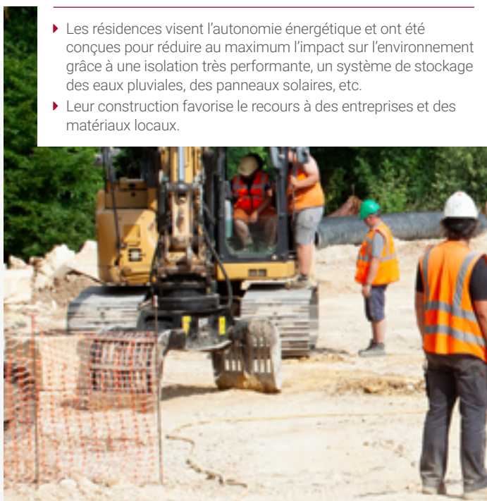
Phase finale du terrassement
