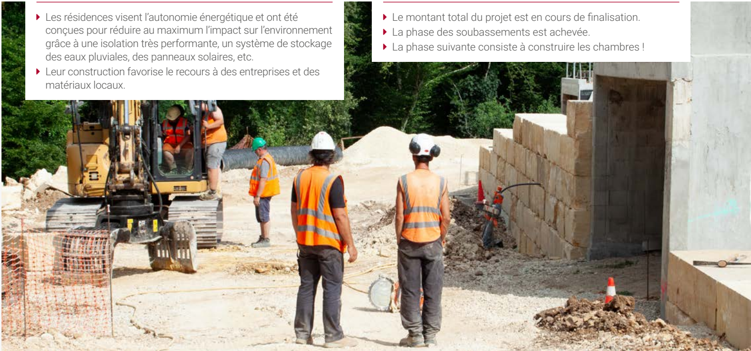
Phase finale du terrassement
